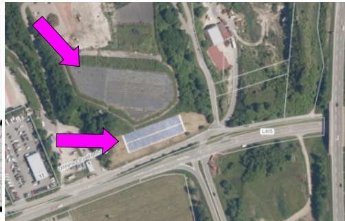
Abb. 4-5: Orthophoto mit realisierten Anlagen
